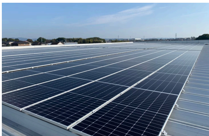
屋上に敷き詰められた太陽光パネルが、工場内で使用する電力の60%以上を発電している
